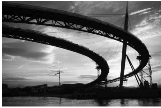
Il costruendo "Ponte del Mare"
